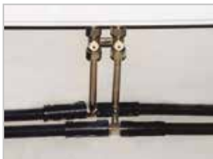
Монтаж с преходна Т-образна връзка
