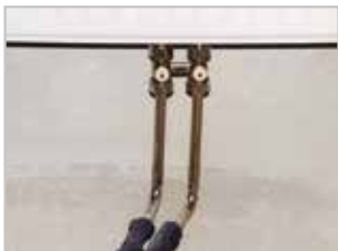
Монтаж със свързващи колена
