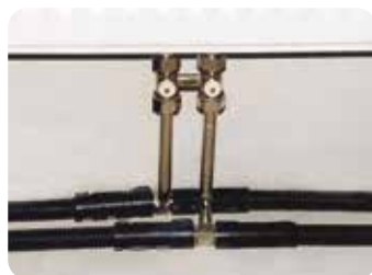
Монтаж с преходна Т-образна връзка
