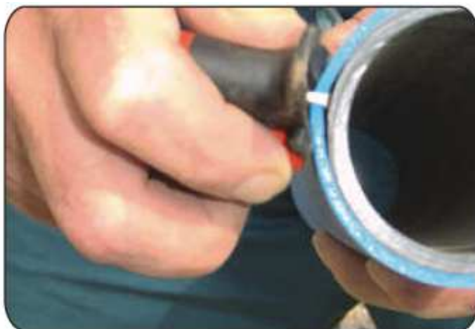
Поставете режещия инструмент между външния и вътрешния слой.
