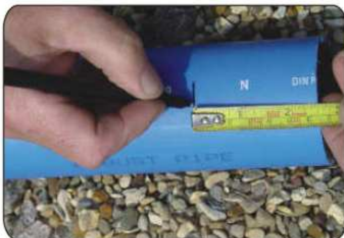
Измерете и маркирайте тръбата.
