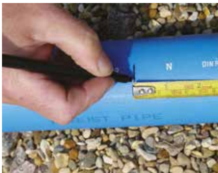
Измерете и маркирайте тръбата.
