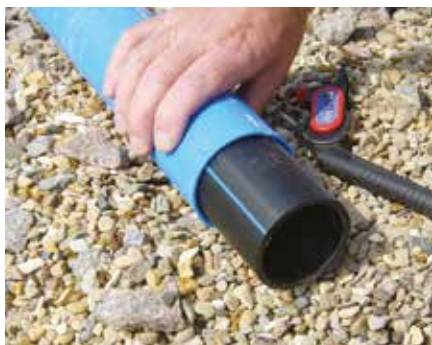
Ивътрешният слой е готов за изглаждане и запояване.
