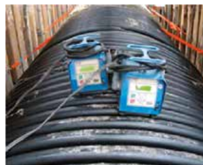
Електрофузионно заваряване на голяма тръба в тесен изкоп
