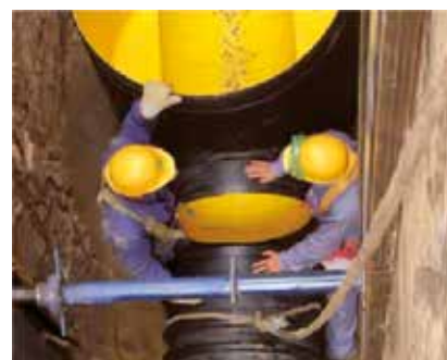
Електрофузионно заваряване на шахта с тръба
