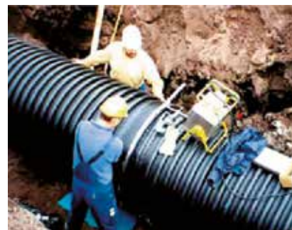
Процес на електрофузионно заваряване
